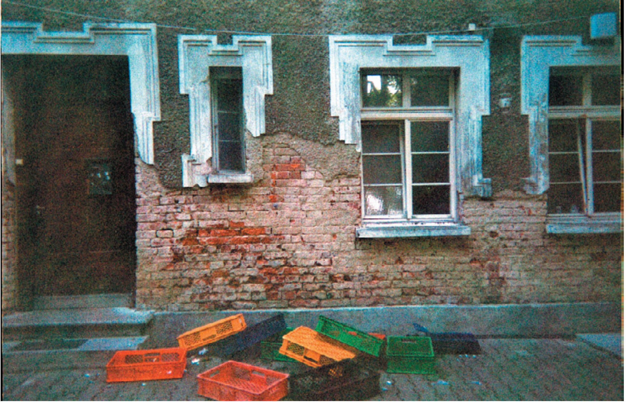
Außenfassade der Flüchtlingsunterkunft
